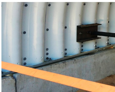
Obr. Spojení ocelové konstrukce s železobetonovými základovými pasy
