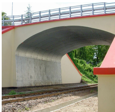
Železobetonová čelní zeď - kolmý konec
