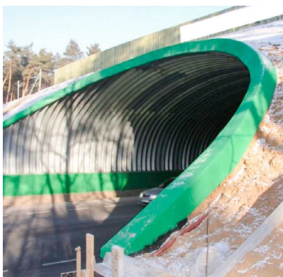
Šikmé čelo s železobetonovým límcem
