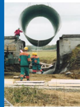
Společnost ViaCon zajistila výrobu ocelového tubusu, dílenský epoxidový nátěr a statické posouzení.
